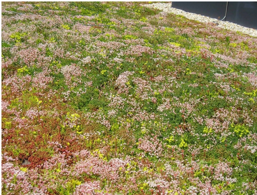
Sedumbegrünung mit der Dachgrün Vegetationsmatte
