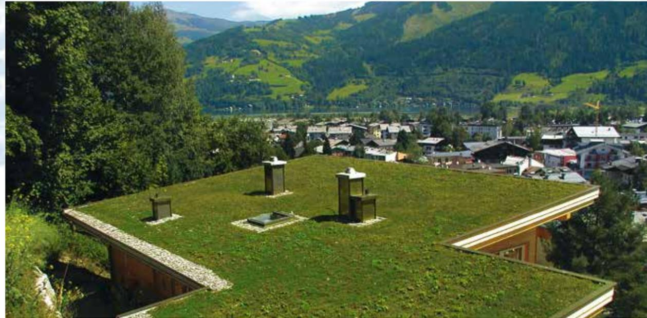
Das System besteht aus vorkultivierten Kunststoffbecherprofilen, welche auf einem Schutzvlies auf die Abdichtung verlegt werden. Diese schnelle und einfache Form der Begrünung birgt zahlreiche Vorteile in sich:
