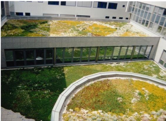
Die Begrünung legt sich wie ein schattierender, kühlender Mantel über die Dachfläche und verhindert so die Aufheizung des Baukörpers. Die Pflanzen filtern außerdem Staub und Schadstoffe aus der Luft, diese werden im Gründachaufbau gebunden und in biologischen Prozessen um- und abgebaut.
