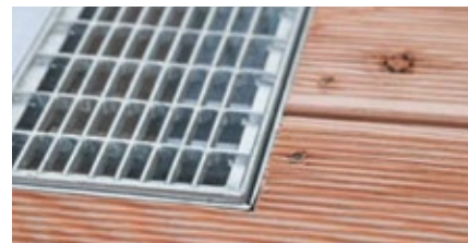
Einbau von Abdeckrosten in Holzbeläge.
